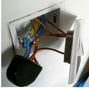
图 2: 壁式开关后面的 T-SW 安装
